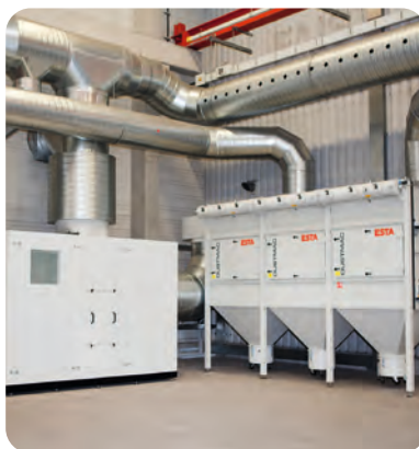
DUSTMAC Filtereinheit mit Absaug- und Zuluftventilator
