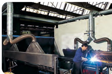
Schlitzabsaughauben im Fahrzeugbau
