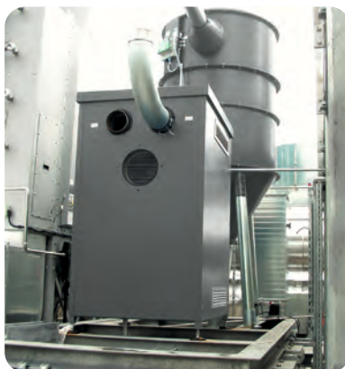
Filtereinheit mit Explosionsschutz
