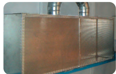
Absaugwand mit Lochblechaufsatz
