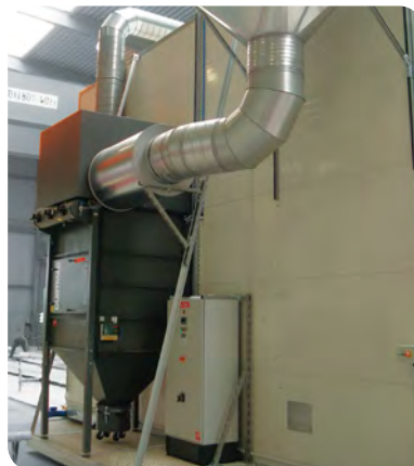
DUSTMAC Filtereinheit an Schleifkabine
