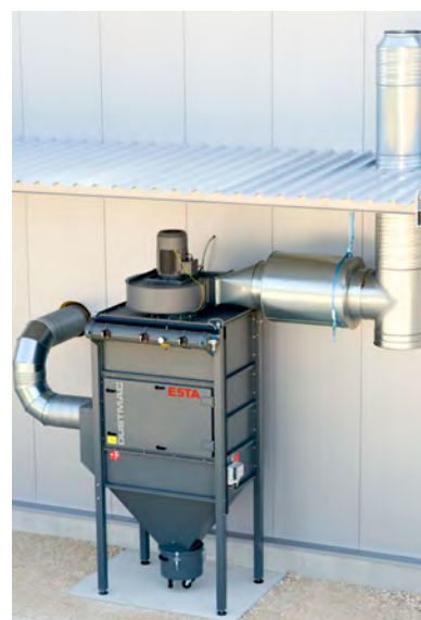
Die DUSTMAC-Reihe ist auch für die Außenaufstellung geeignet
