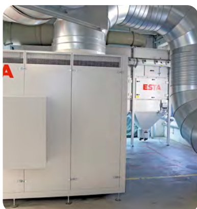
Absaugsystem in separatem Raum
