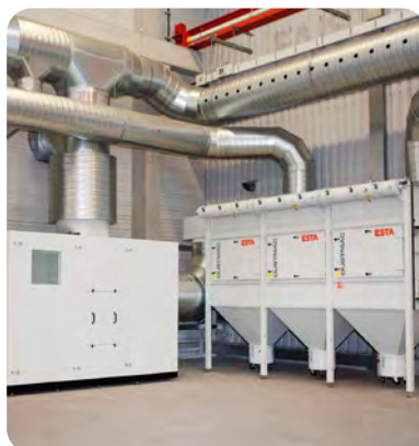
DUSTMAC Filtereinheit mit Absaug- und Zuluftventilator
