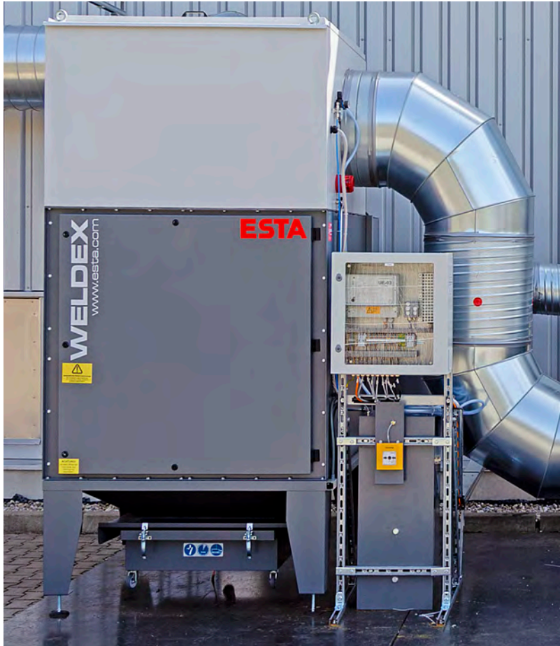
Zentrale Filtereinheit mit Löschanlage in einem Schweißrauch-Absaugsystem
