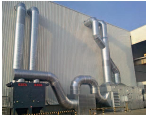
Metallbearbeitung – Absaugsystem mit Wärmerückgewinnung.
