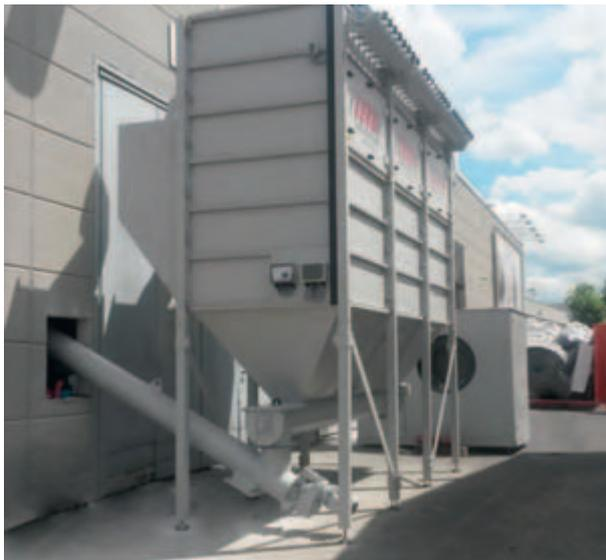
Absauganlage mit Förderschnecke als Zuführung zu einer Brikettierpresse.
