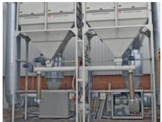
Zentrale Absauganlage mit zwei Zellenradschleusen zum kontinuierlichen Austrag von Ziegelstaub.
