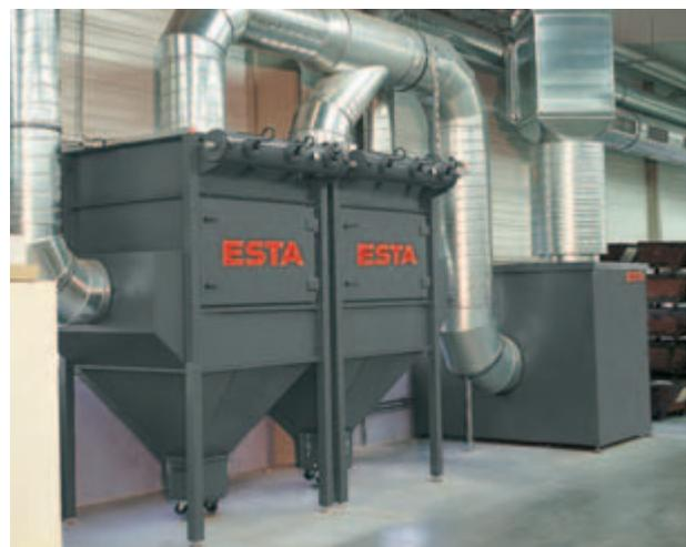
Maschinenbau – ESTA Anlage mit Schalldämpfer und Luftrückführung.
