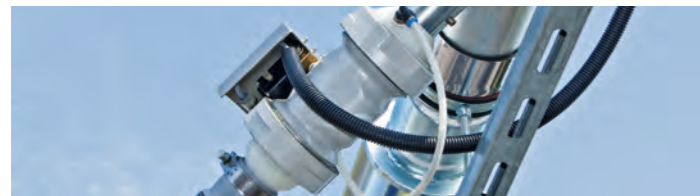
Schlauch-Quetschventil mit Druckluftsteuerung für den münzbetriebenen zentralen Sauger
