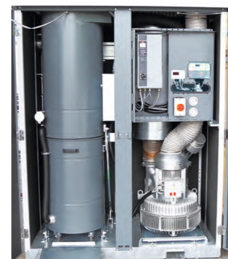
Das Innenleben des CCCS 2.0. Links: Filtereinheit mit Staubsammelbehälter Rechts: Seitenkanalverdichter und Schaltelemente
