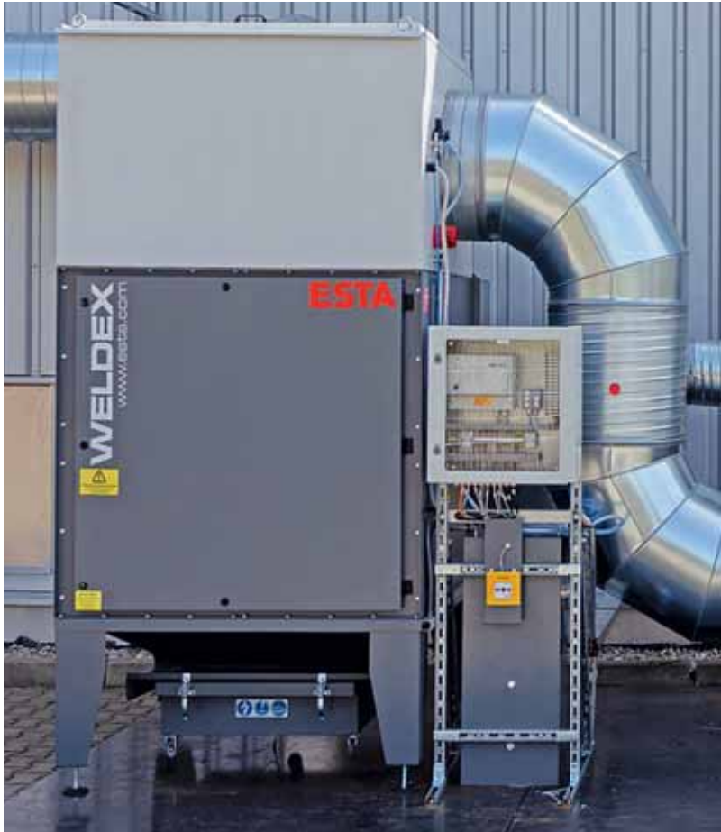
Zentrale Filtereinheit mit Löschanlage in einem Schweißrauch-Absaugsystem
