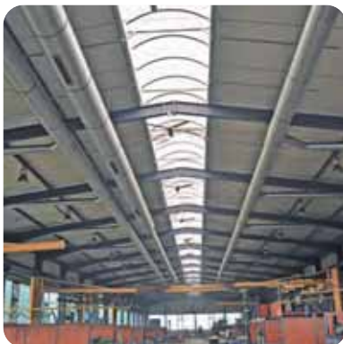
Rohrleitungssystem in der Produktionshalle
