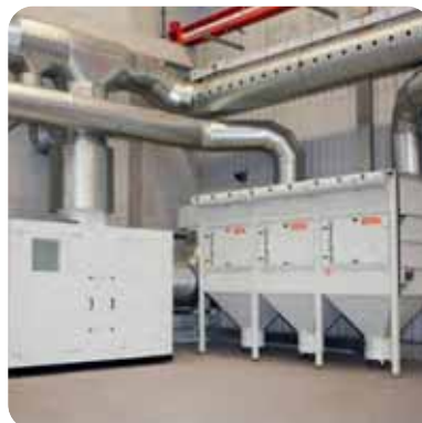
DUSTMAC Filtereinheit mit Absaug- und Zuluftventilator
