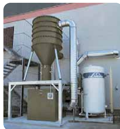
Filterzyklon auf einer Stahlkonstruktion
