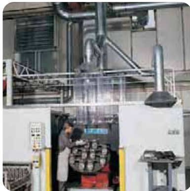
Absaugung an einem Roboterarbeitsplatz
