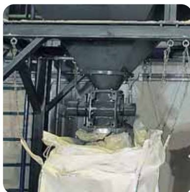
Austrag über Zellenrad schleuse in einen bauseitigen BigBag (optional)
