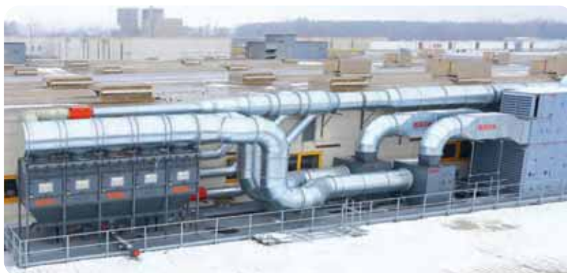
Absaugsystem ist auf dem Dach der Produktionshalle installiert
