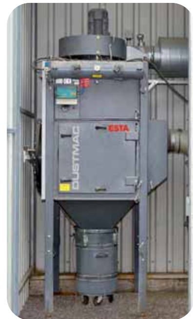
Absauganlage DUSTMAC F in der Chemie-Industrie
