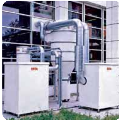
Absauganlage in Sonderlackierung im Freien aufgestellt
