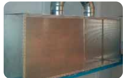
Absaugwand mit Lochblechaufsatz
