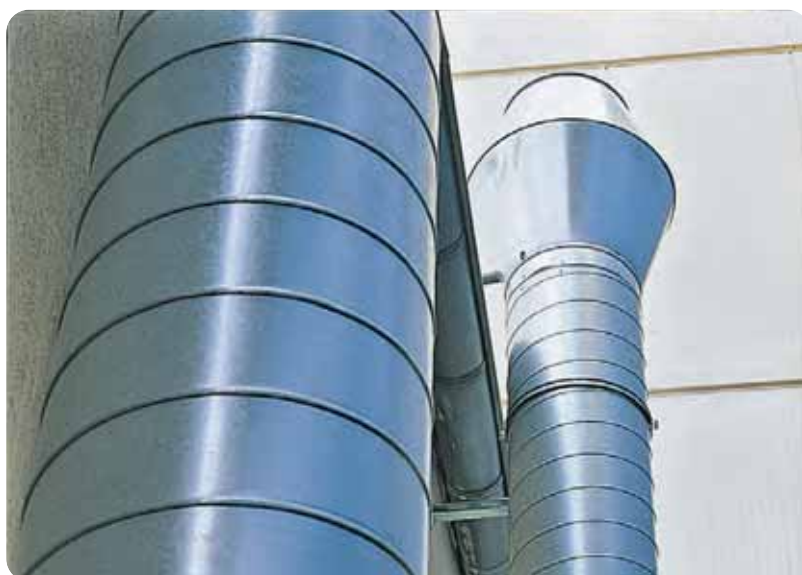
Abluftrohrleitung mit Deflektorhaube
