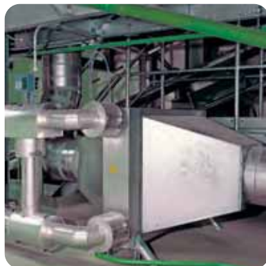
Rohrleitungssystem für Abluft mit integrier- tem Kühler
