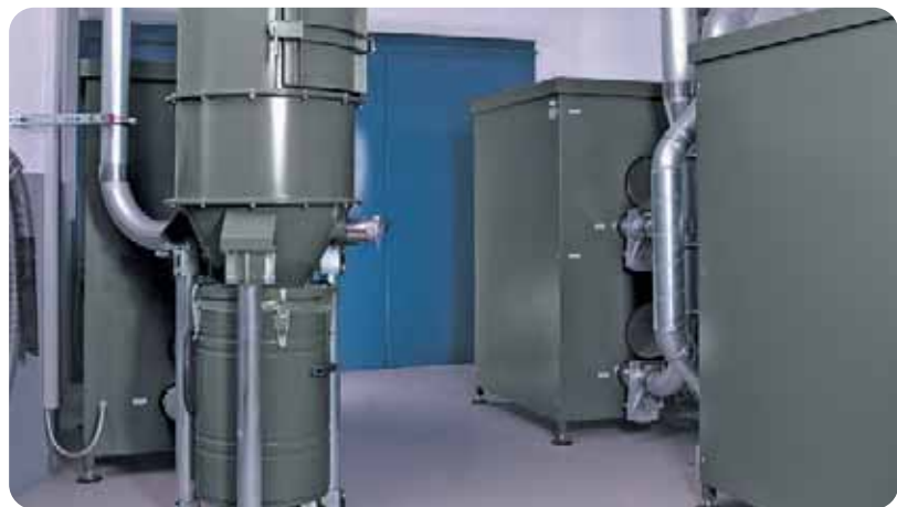
Zentrale Staubsaugereinheit mit zwei Seitenkanalverdichtern ausgestattet
