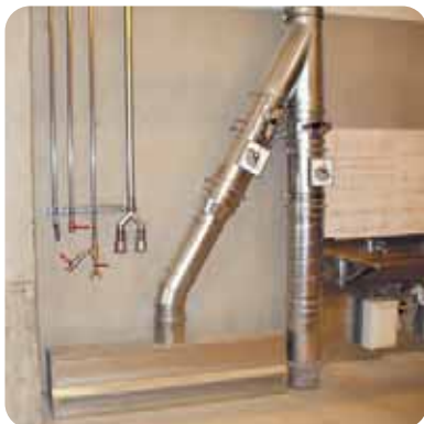
Staubfassung durch spezielles Rohrleitungssystem
