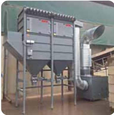
Absaugereinheiten DUSTMAC S-66 und Mitteldruckventilator
