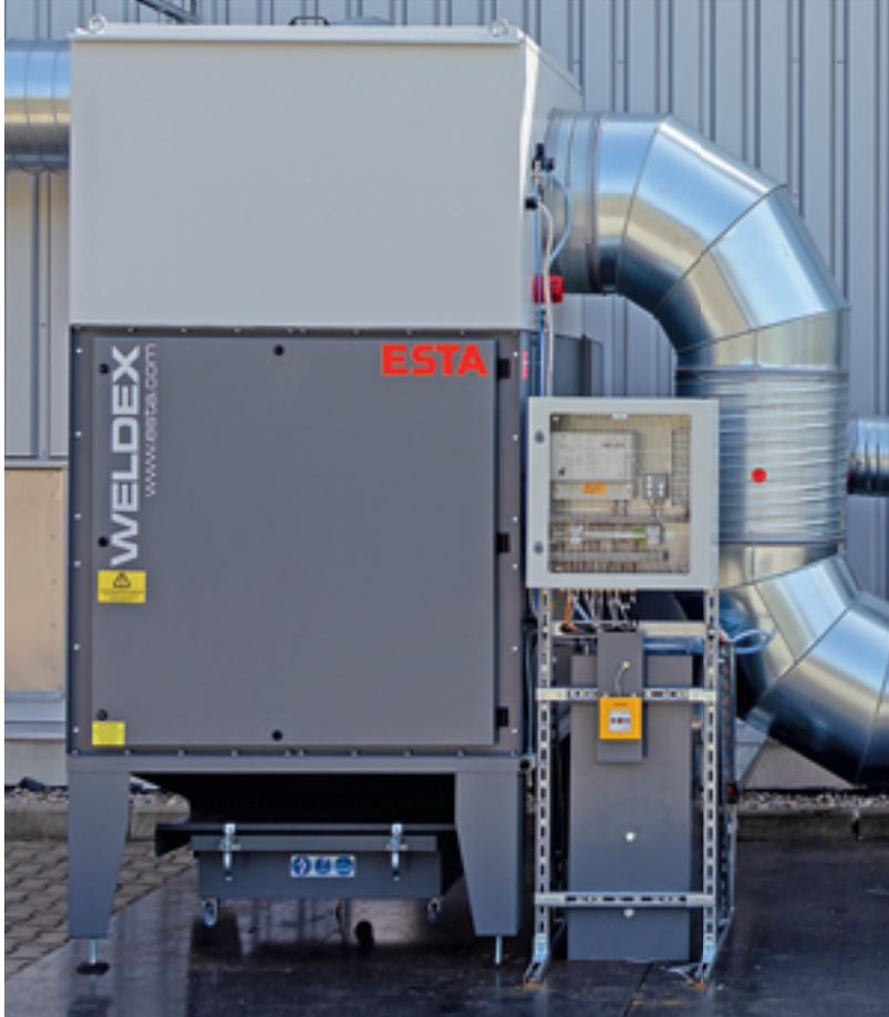
Zentrale Filtereinheit mit Löschanlage in einem Schweißrauch-Absaugsystem
