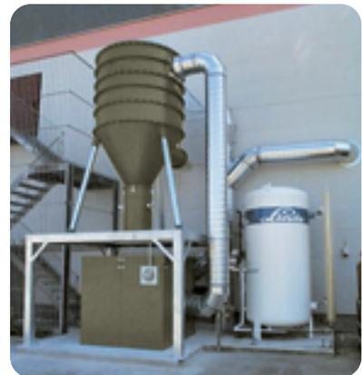
Filterzyklon auf einer Stahlkonstruktion
