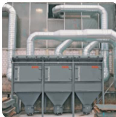
Modular aufgebaute Filtereinheit
