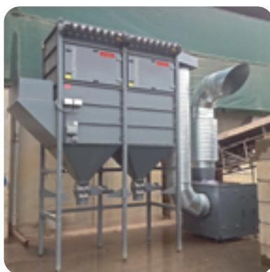
Absaugereinheiten DUSTMAC S-66 und Mitteldruckventilator
