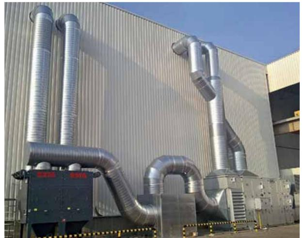
Metallbearbeitung – Absaugsystem mit Wärmerückgewinnung.
