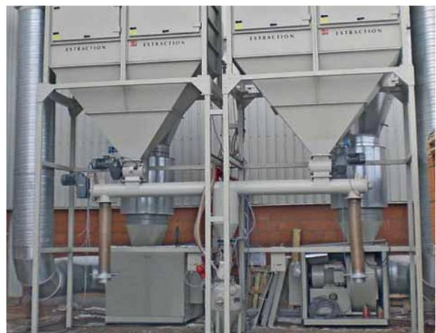
Zentrale Absauganlage mit zwei Zellenradschleusen zum kontinuierlichen Austrag von Ziegelstaub.
