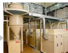
Hochvakuumabsaugung zur Maschinenreinigung
