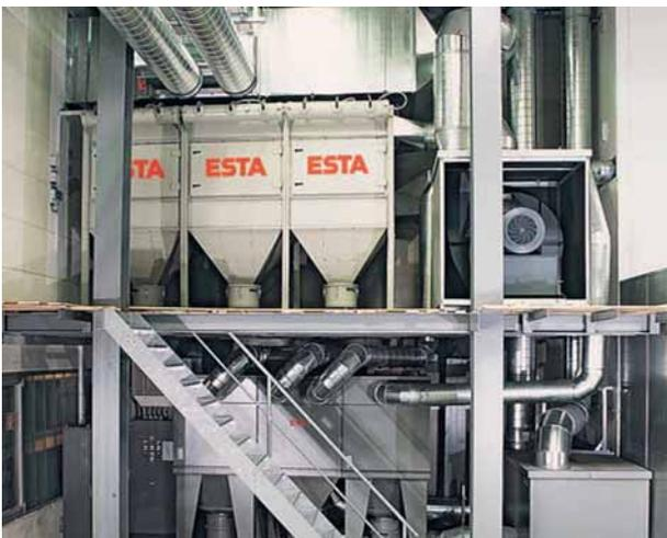
Fahrzeugbau – Absauganlage in einer Schalleinhausung auf zwei Etagen.
