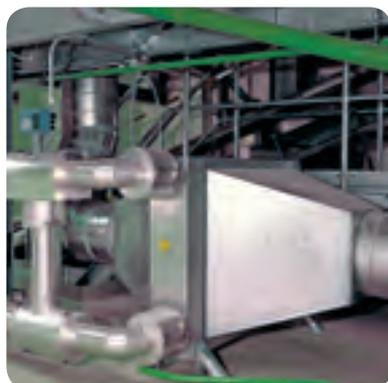
Rohrleitungssystem für Abluft mit integriertem Kühler
