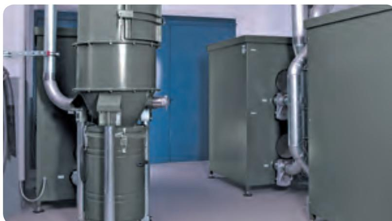
Zentrale Staubsaugereinheit mit zwei Seitenkanalverdichtern ausgestattet
