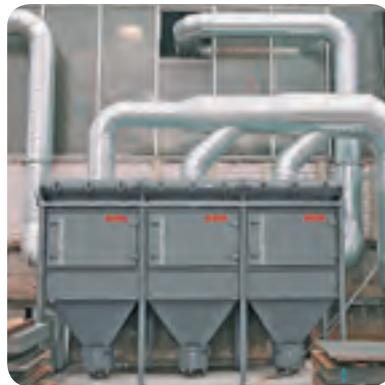
Modular aufgebaute Filtereinheit
