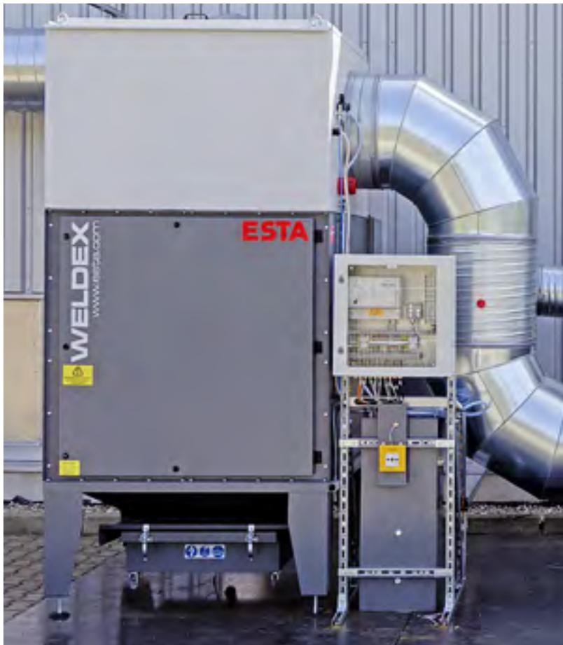
Zentrale Filtereinheit mit Löschanlage in einem Schweißrauch-Absaugsystem
