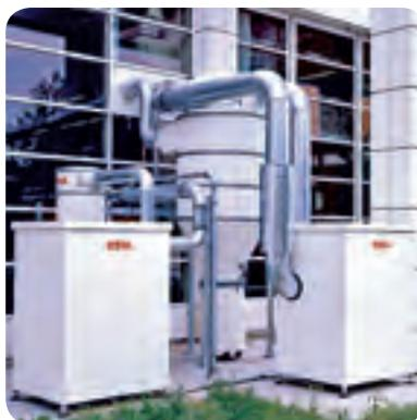
Absauganlage in Sonderlackierung im Freien aufgestellt
