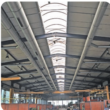
Rohrleitungssystem in der Produktionshalle
