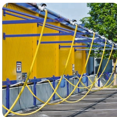
Ein fest installiertes Rohrsystem verbindet die Saugstellen mit dem CENTRAL CAR CLEANING SYSTEM
