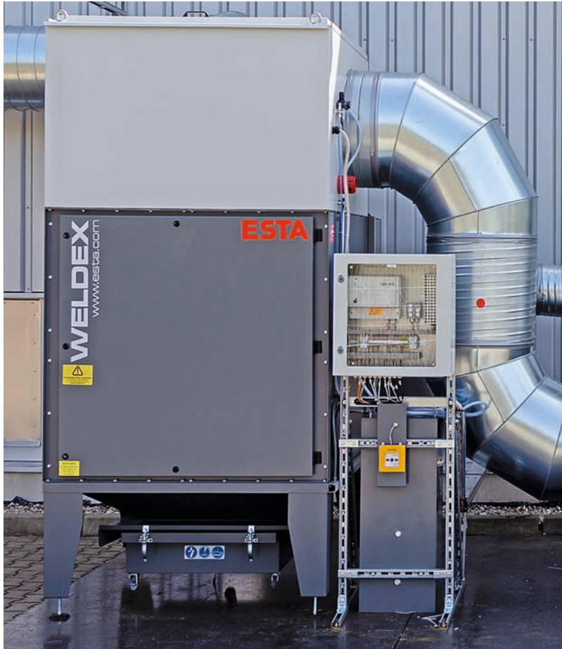
Zentrale Filtereinheit mit Löschanlage in einem Schweißrauch-Absaugsystem
