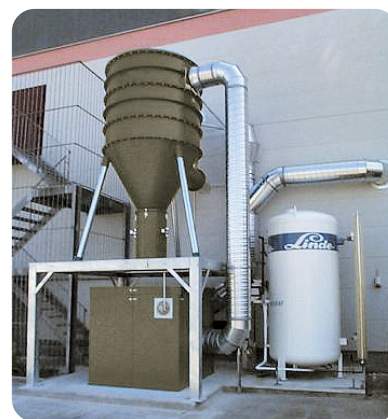
Filterzyklon auf einer Stahlkonstruktion
