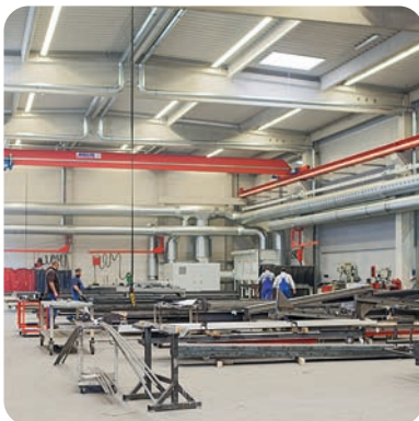
Produktionshalle mit 24 Schweißarbeitsplätzen
