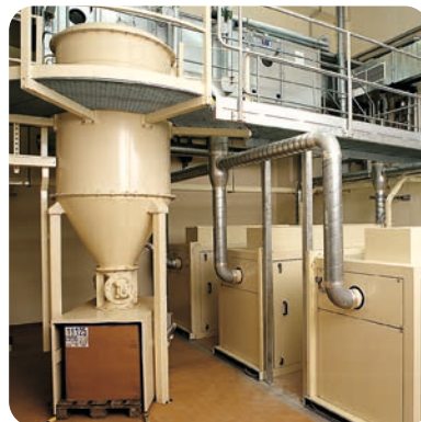
Filtersystem mit Staubaustrag über Zellrad-schleuse und parallel geschalteten Drehkolbengebläsen
