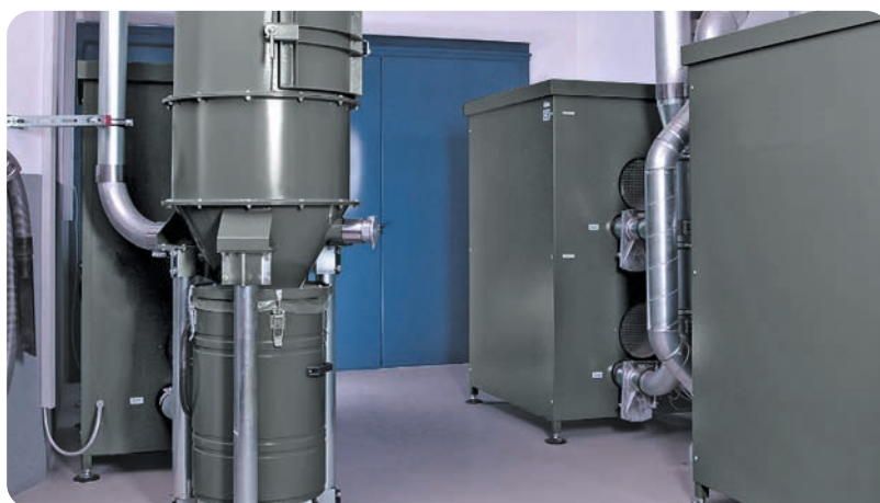
Zentrale Staubsaugereinheit mit zwei Seitenkanalverdichtern ausgestattet
