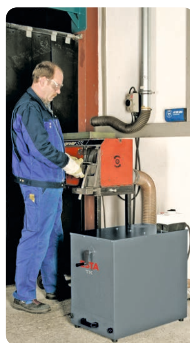
Kleinentstauber TK an einer Entgratmaschine
