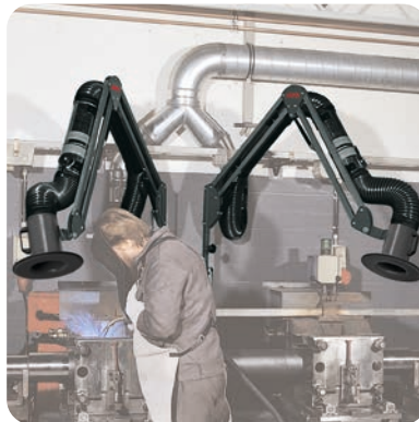
Absaugarme an einem Schweißplatz
