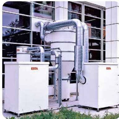
Absauganlage in Sonderlackierung im Freien aufgestellt
