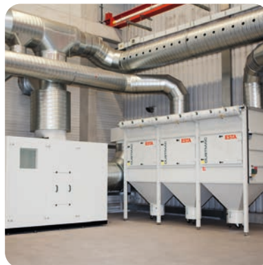
DUSTMAC Filtereinheit mit Absaug- und Zuluftventilator
