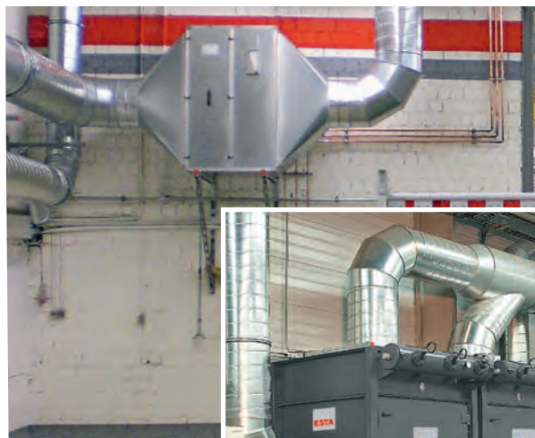
Nachfilter an einer Filteranlage in einem metallverarbeitenden Betrieb
