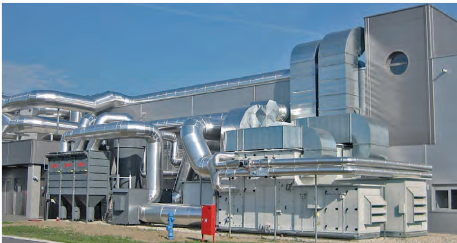
Zentrale Absauganlage mit Wickelfalzrohrsystem in der Schuhindustrie
