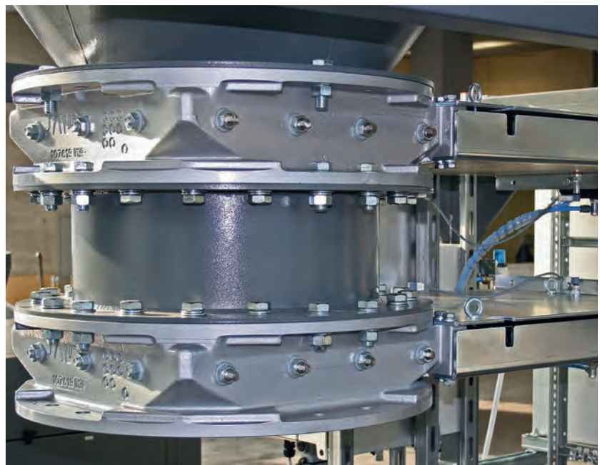
Zwei pneumatische Prozessschieber an einem Filterzyklon zum Austrag von Schüttgut in einen Big Bag
