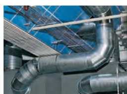
Verbindungsrohr zwischen Ventilator und Filteranlage
