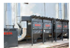
Rohrsystem als Zuleitung für zentrale Absauganlage
