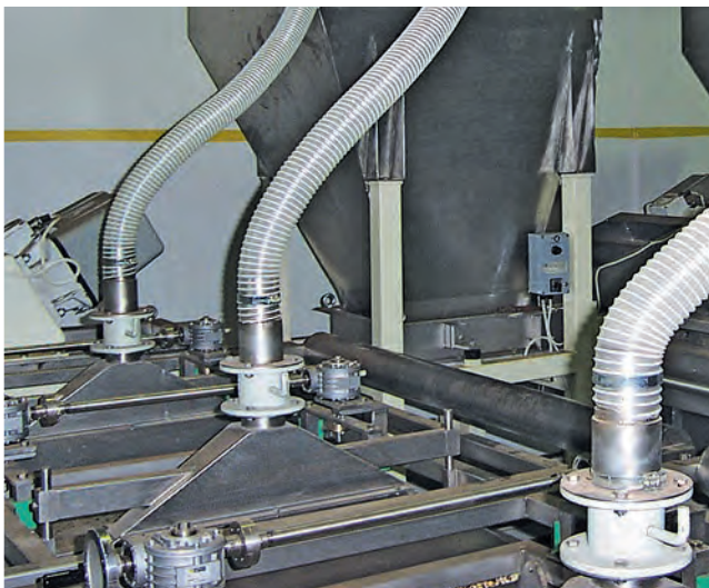
PU-Schläuche zur Verbindung der Absaughauben mit dem Rohrsystem in einem metallverarbeitenden Betrieb
