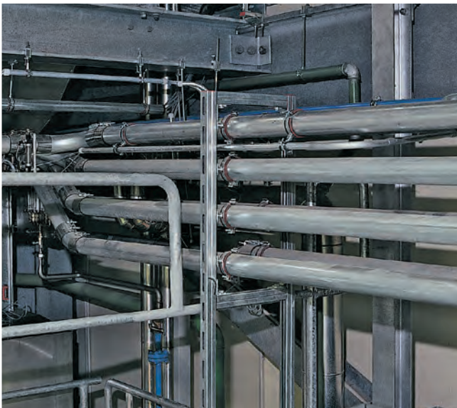
Stahlrohrsystem einer zentralen Absauganlage in der Tabakindustrie
