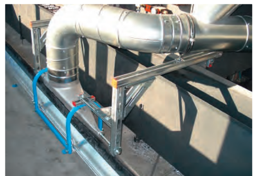
Saugschlitzkanal zur Absaugung von Metallspänen
