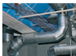
Verbindungsrohr zwischen Ventilator und Filteranlage
