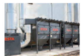
Rohrsystem als Zuleitung für zentrale Absauganlage
