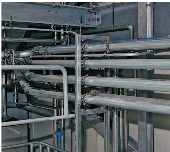
Stahlrohrsystem einer zentralen Absauganlage in der Tabakindustrie
