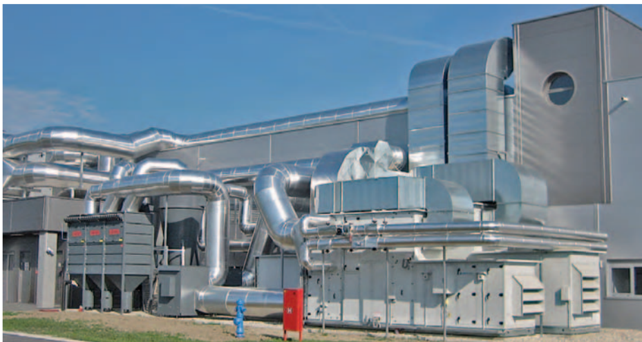
Zentrale Absauganlage mit Wickelfalzrohrsystem in der Schuhindustrie
