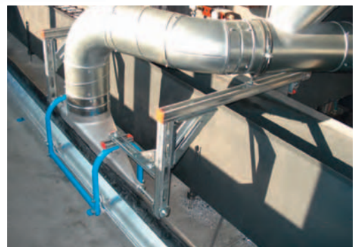
Saug Schlitzkanal zur Absaugung von Metallspänen
