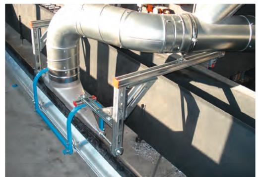
Saugschlitzkanal zur Absaugung von Metallspänen
