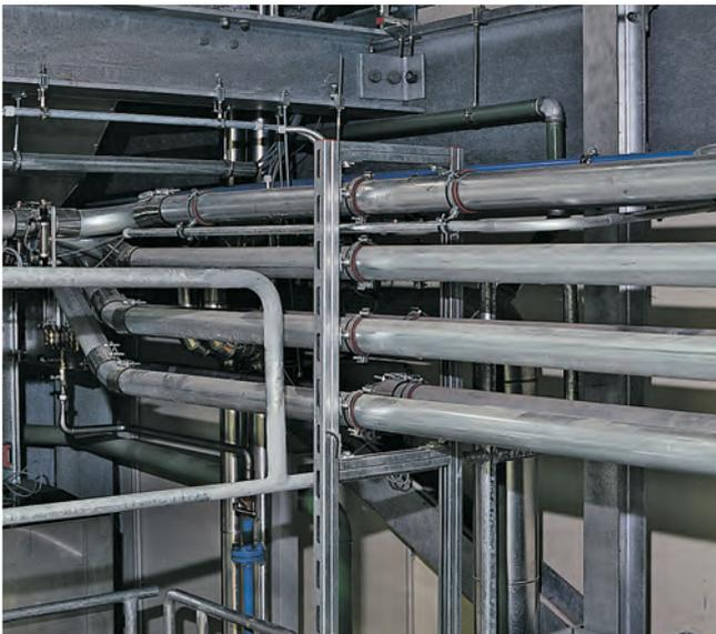
Stahlrohrsystem einer zentralen Absauganlage in der Tabakindustrie
