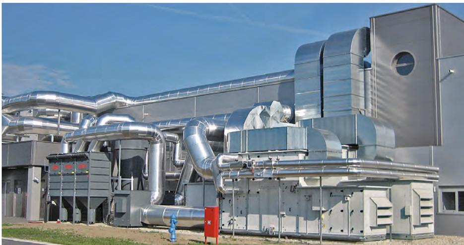
Zentrale Absauganlage mit Wickelfalzrohrsystem in der Schuhindustrie
