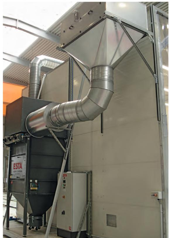
Modulare ESTA Absauganlage DUSTMAC F-144 mit Nachfilter zur Absaugung von GFK-Schleifstaub
