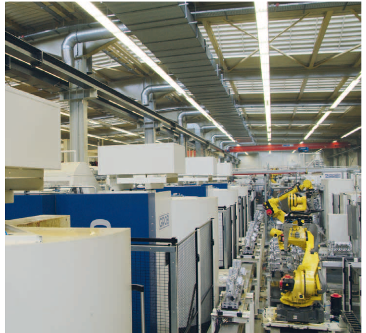
Bild 18 Dezentrale Absauganlage mit Einzelabscheidung
