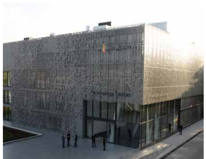
Das Technology Center der Walter AG bietet auf 5.000 m 2 Einblicke in eine Fabrik der Zukunft, die heute schon Wirklichkeit ist.
