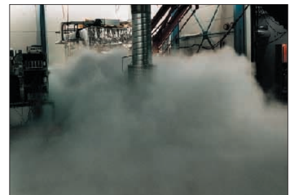
Bild 13: Strömungsbild eines Quellluftdurchlasses
