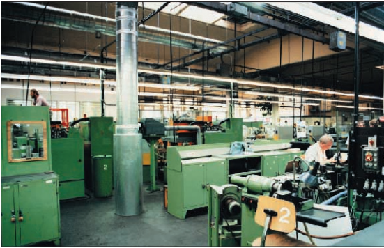
Bild 14: Quelllüftung in einer Fertigungshalle
