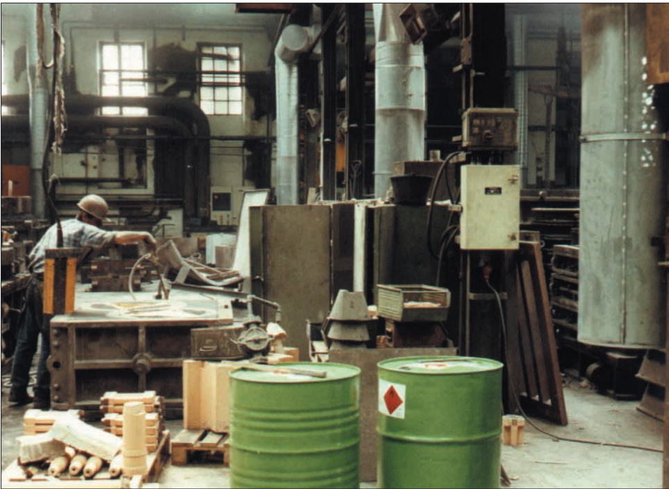
Bild 15: Quelllüftung in einer Kernmacherei
