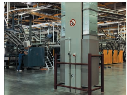
Bild 14: Quelllüftung in einer Fertigungshalle
