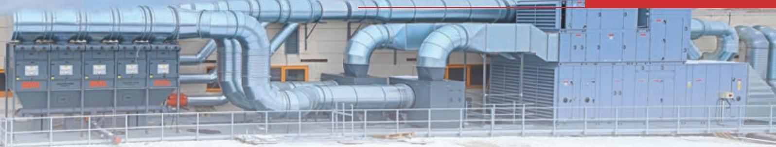
Heizkosten einsparen: Esta entwickelt Absaugsysteme mit Wärmerückgewinnung, um die Ressourceneffizienz in den Produktionshallen zu erhöhen.
