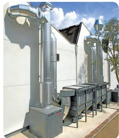
Installation de dépoussiérage avec deux modules DUSTMAC S
