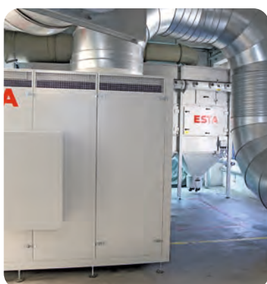
Absaugsystem in separatem Raum
