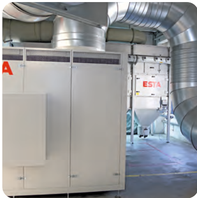
Absaugsystem in separatem Raum
