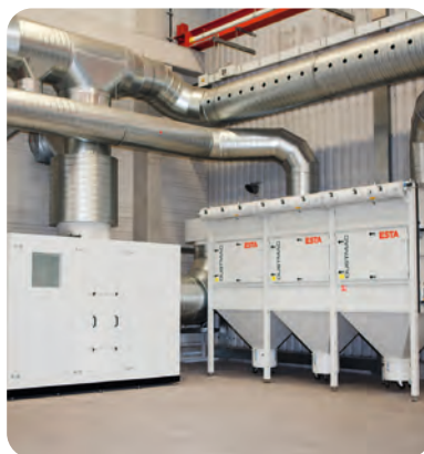
DUSTMAC Filtereinheit mit Absaug- und Zuluftventilator
