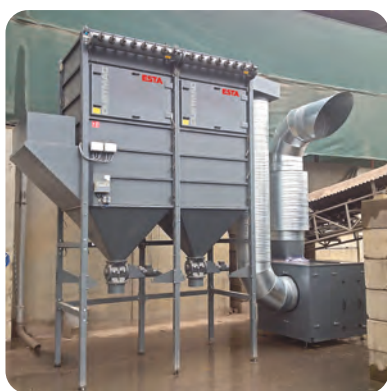
Absaugereinheiten DUSTMAC S-66 und Mitteldruckventilator
