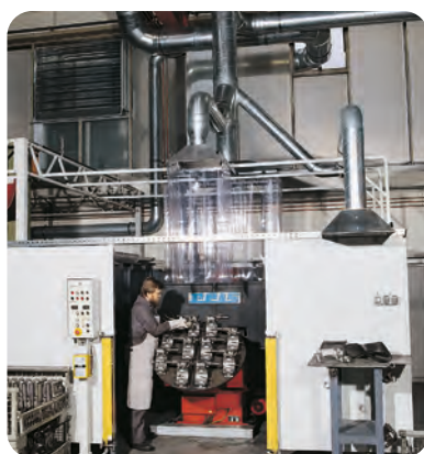
Absaugung an einem Roboterarbeitsplatz
