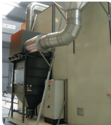
DUSTMAC Filtereinheit an Schleifkabine
